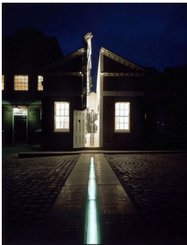
Figura 2 Na imagem é possível ver o edifício que alberga o principal telescópio de trânsito circular do antigo observatório de Greenwich. Repare-se que o telhado do edifício foi recolhido por forma a deixar uma estreita faixa de observação, a qual está alinhada com a linha meridiana imaginária , representada por uma guia metálica no solo, visível até à porta do edifício e à base do telescópio. Foto do Observatório Real de Greenwich.
